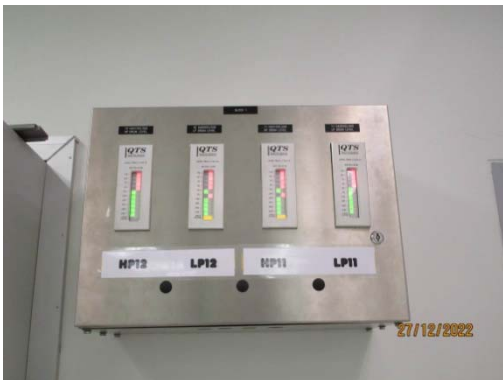
รูปที่ 50 มาตรวัดระดับน้ำและระบบสัญญาณเตือน
