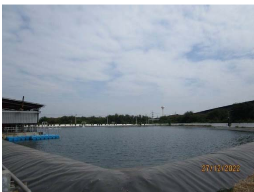
รูปที่ 9 บ่อน้ำดิบขนาด 35,000 ลูกบาศก์เมตร
