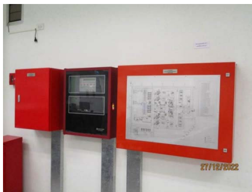
รูปที่ 31 ระบบสัญญาณเตือนภัย (Fire alarm)
