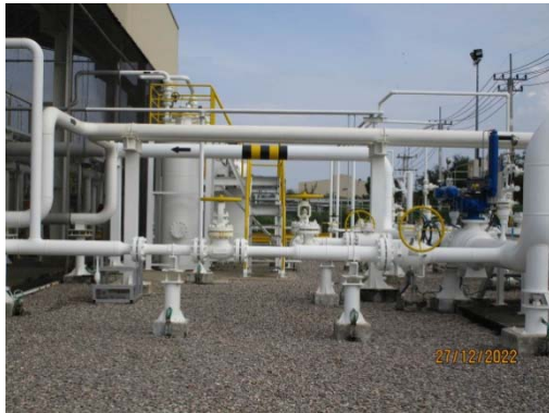
รูปที่ 57 ระบบท่อ Bypass และระบบวาล์วสำรอง
