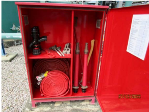
รูปที่ 39 ตู้เก็บอุปกรณ์สำหรับดับเพลิง
