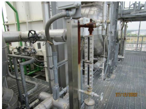
รูปที่ 50 มาตรวัดระดับน้ำและระบบสัญญาณเตือน
