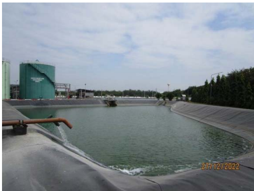
รูปที่ 7 บ่อพักน้ำทิ้งขนาด 5,000 ลูกบาศก์เมตร
