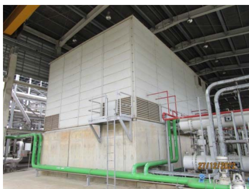
รูปที่ 14 อาคารปิดครอบเครื่องจักรที่มีเสียงดัง
